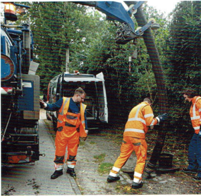
Sanierung Grüneneck - U Hartmann
